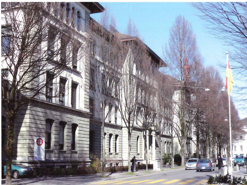
Die Kantonsschule am Hirschengraben, erbaut 1891–1893 von Heinrich Viktor von Segesser nach Plänen von Eugen Meyer. Heute Fach- und Wirtschaftsmittelschule des Kantons Luzern.
