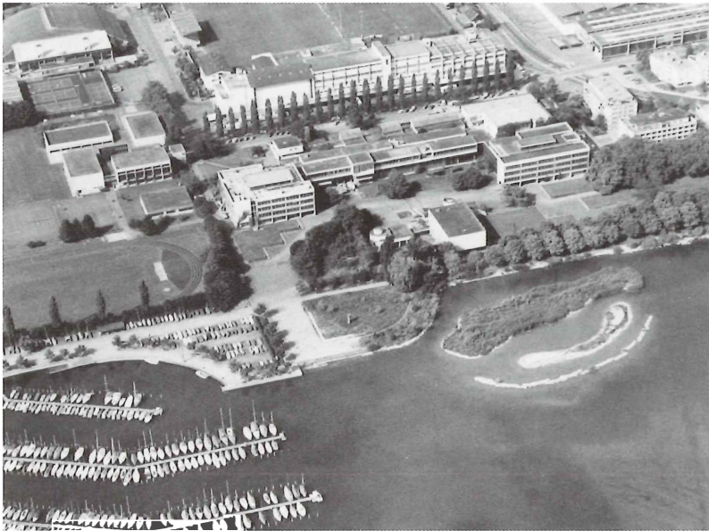
Blick auf die fertig gestellte Kantonsschule. (Bild: Archiv Hans Eggstein)
