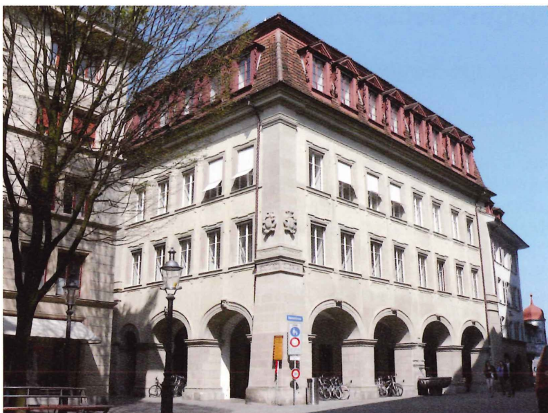
Das neue Jesuitengymnasium Ecke Krongasse/Bahnhofstrasse, erbaut 1729–1731. Heute befindet sich hier das Bildungs- und Kulturdepartement.
