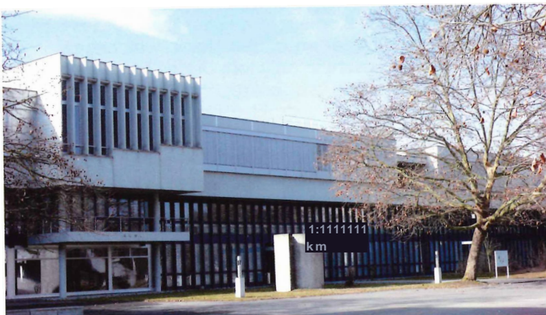
Verbindungstrakt mit abgesetztem Physikzimmer, Seeseite
