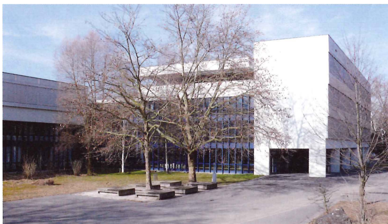
Übergang vom Spezialtrakt zum Roten Trakt, Seeseite
